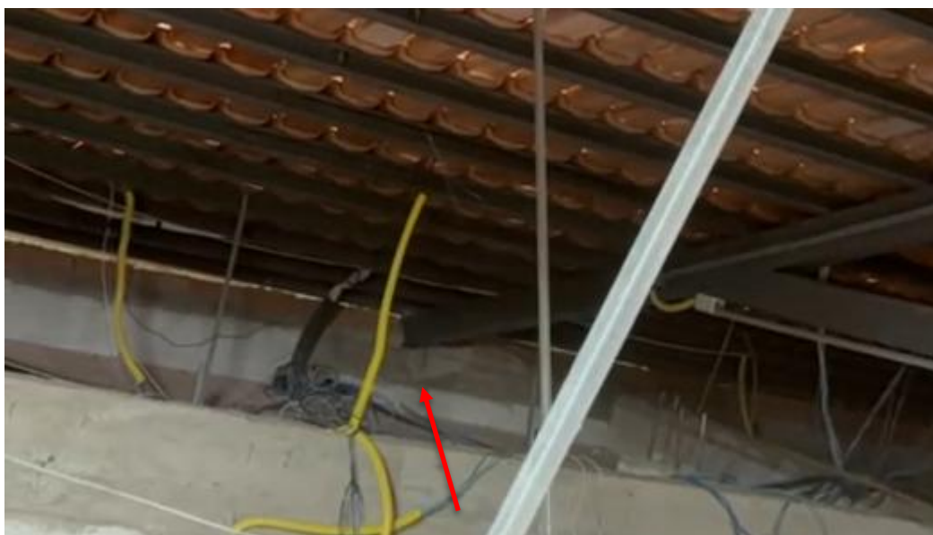
Figura 11 – Em outro ponto, observa-se a mesma condição: tesoura apenas apoiada sobre a viga de concreto, sem fixação adequada, repetindo a falha de execução.
