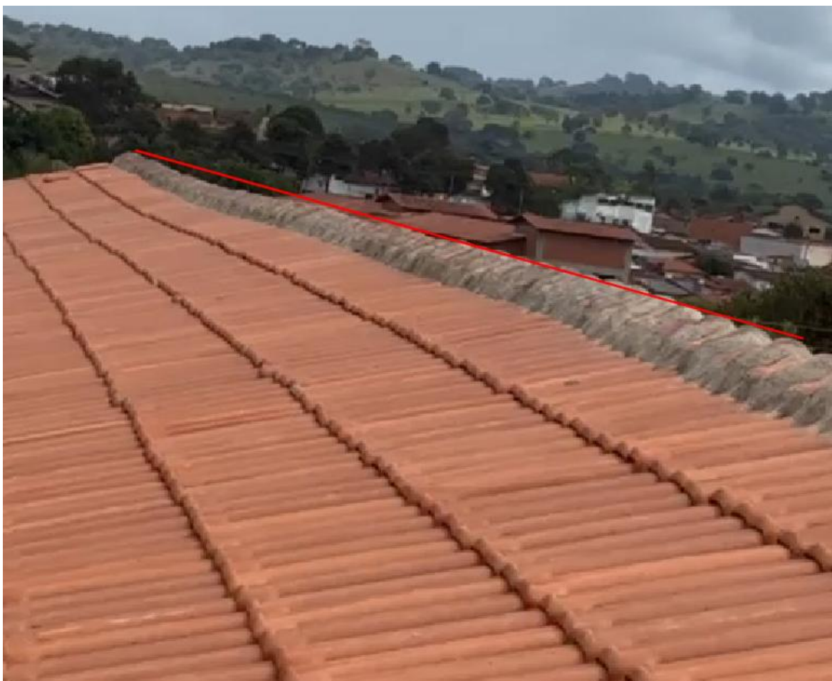
Figura 2 – Observa-se o lado direito do Bloco 01, onde a estrutura da cobertura encontra-se selada. A linha reta vermelha inserida na imagem evidencia visualmente a deformação dos elementos estruturais, indicando desvios significativos de alinhamento que comprometem a geometria e a estabilidade da estrutura.
