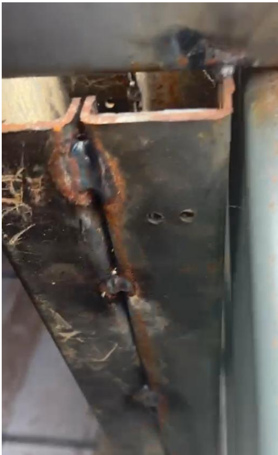
Figura 9 – Vista lateral do elemento denominado "reforço estrutural", onde se constata a quase total ausência de contato com a tesoura metálica. Essa execução inadequada compromete completamente sua função estrutural, impedindo a transferência de esforços entre os elementos.
