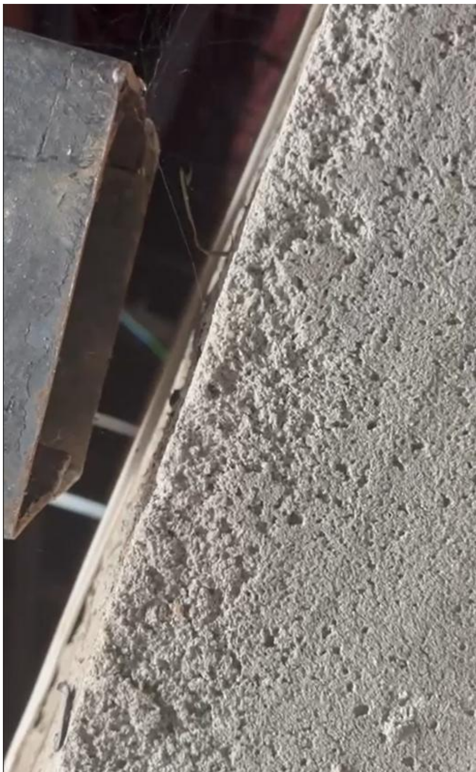
Figura 6 – A imagem, capturada por baixo, evidencia com clareza que o elemento denominado "reforço estrutural" encontra-se sem qualquer apoio na viga de concreto, permanecendo em balanço.
