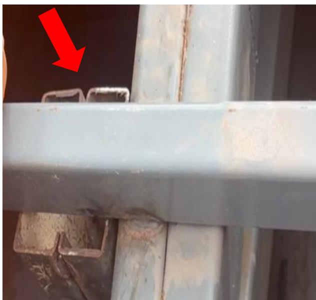
Figura 8 – Vista superior do "reforço estrutural", destacado pela seta vermelha, em desacordo com o projeto "As Built", foi instalado lateralmente à tesoura e em balanço, sem qualquer conexão com a viga de concreto. Essa disposição descaracteriza sua função como elemento de reforço. Fonte: Elaboração do autor (2025).
