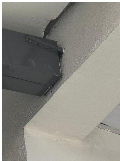
Figura 33 – À esquerda, a imagem ilustra as vigas de cobertura do pátio coberto, montadas na lateral do Bloco 01 e nas tesouras do Bloco 02. À direita, é apresentado o detalhe da fixação da viga metálica na lateral do Bloco 01, realizada por meio de vergalhão de concreto armado.
