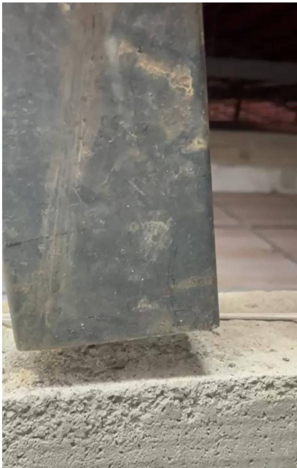
Figura 5 – Os supostos "reforços estruturais" das Tesouras 03, 05, 07, 09, 10 e 11 do Bloco 01 não estão apoiados sobre a viga de concreto, encontrando-se em balanço, ou seja, flutuando no ar. Nessa condição, os elementos não cumprem a função estrutural para a qual foram designados, atuando apenas como carga adicional sobre a estrutura existente, o que contribui negativamente para o desempenho global do sistema. Fonte: Elaboração do autor (2025).
