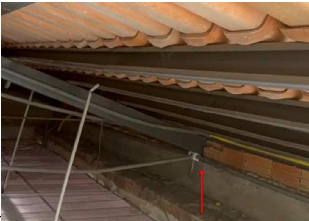
Figura 10 – A seta vermelha mostra a tesoura apenas apoiada sobre a viga de concreto, sem fixação por chapas de base ou chumbadores, em desacordo com o projeto e comprometendo a estabilidade da estrutura.
