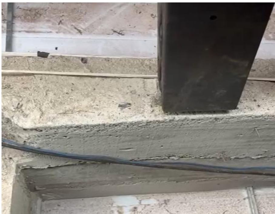
Figura 7 – Nesta imagem, registrada em outro ponto da estrutura, observa-se novamente a condição inadequada do chamado "reforço estrutural", que permanece sem apoio sobre a viga de concreto. A repetição desse problema em diferentes trechos da cobertura confirma que se trata de uma falha recorrente na execução, indicando ausência de critério técnico adequado na instalação desses elementos. Fonte: Elaboração do autor (2025).
