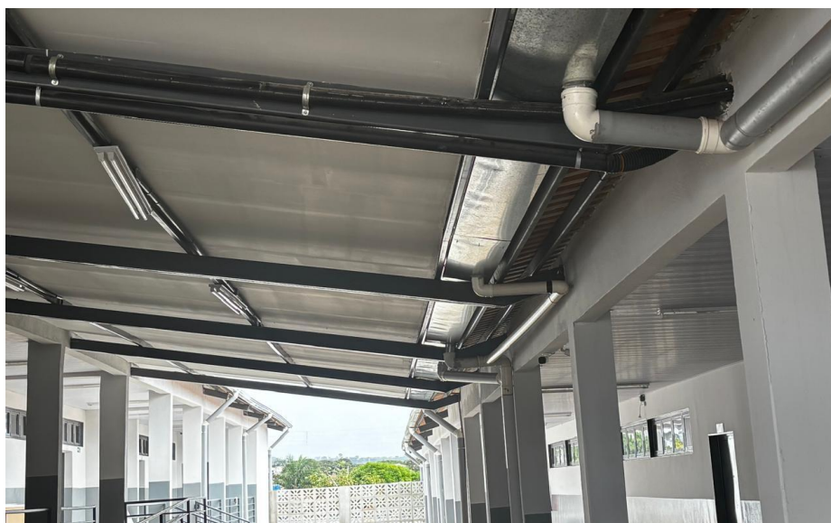
Figura 15 – Além disso, as tesouras do Bloco 02 foram utilizadas para apoiar as vigas de cobertura do pátio coberto, resultando em esforços adicionais nas tesouras.
