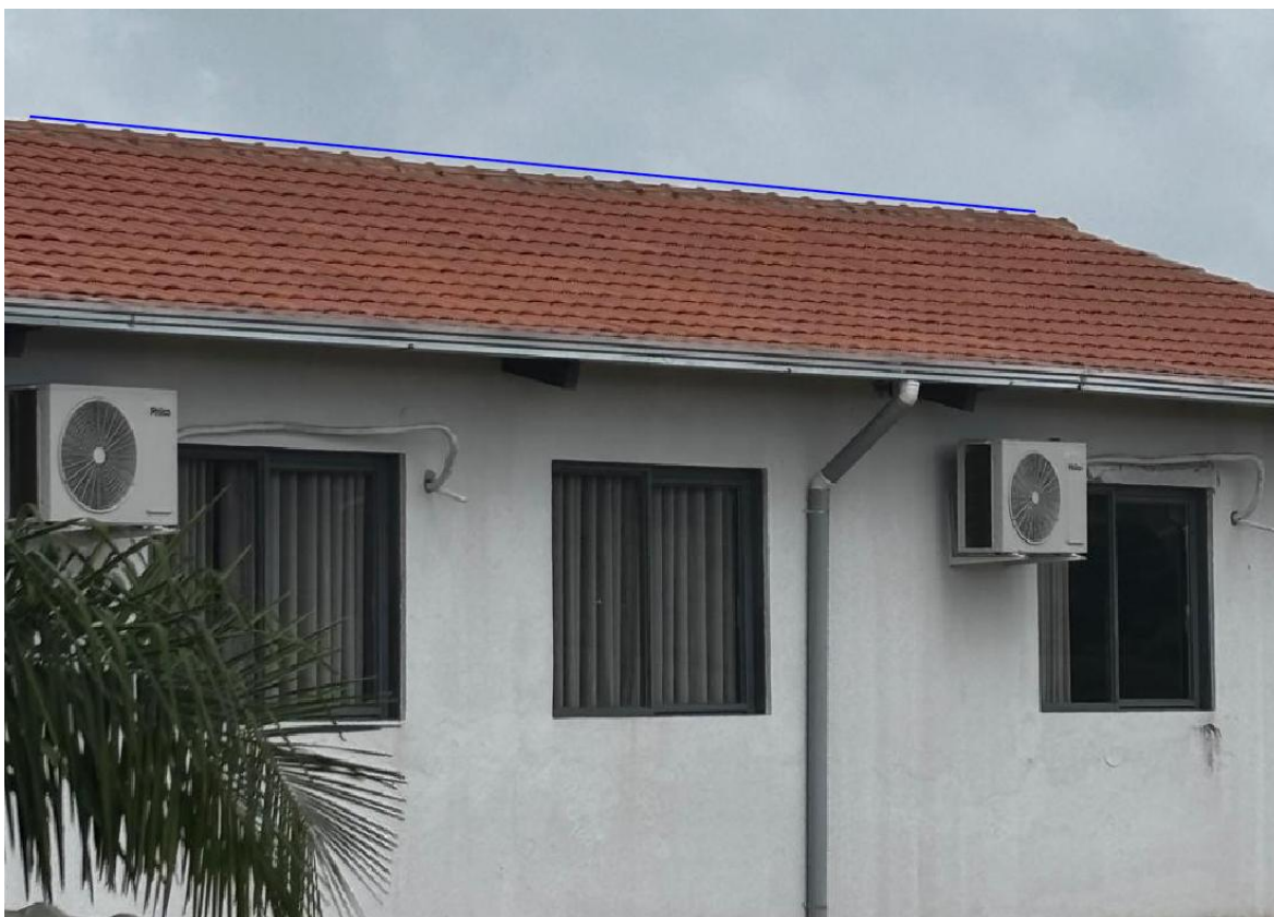
Figura 14 – A linha azul na imagem, conectando os dois pontos do Bloco 02, evidencia que a estrutura deste bloco também apresenta selagem, indicando deformações semelhantes às observadas no Bloco 01.
