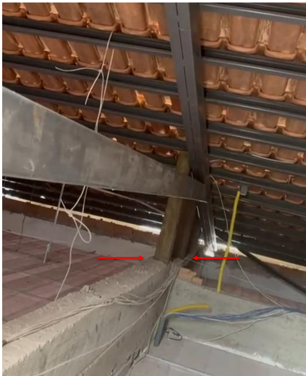
Figura 12 – A imagem, destacada pelas setas vermelhas, exhibe o reforço estrutural instalado sem chapas de base e chumbadores, evidenciando a falta de fixação adequada e o não cumprimento das especificações do projeto.
