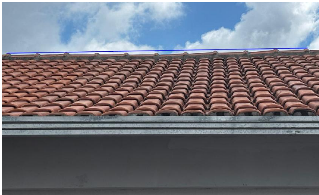
Figura 3 – Bloco 01: Linha azul traçada na região central da cobertura evidencia deformações nos perfis estruturais, que se desviam significativamente da linha de referência. Essas irregularidades indicam perda de alinhamento e possível comprometimento da rigidez e estabilidade da estrutura.
