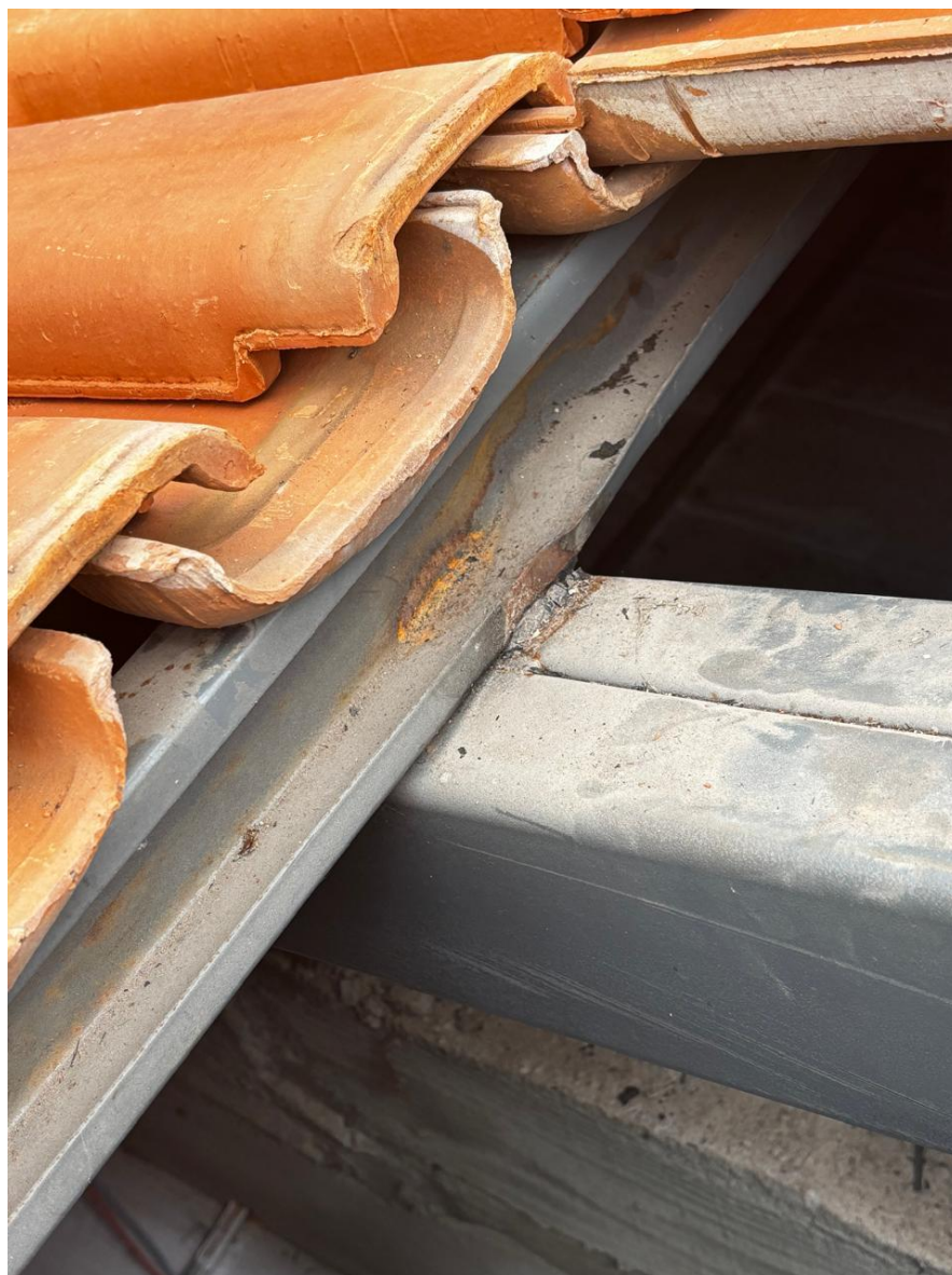
Figura 13 – A imagem destaca a solda mal executada entre a terça e a tesoura, além de evidenciar o amassado no perfil da terça, comprometendo a integridade e a resistência da união entre os elementos. Fonte: Elaboração do autor (2025).
